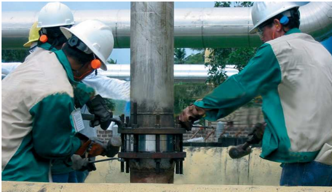
Foto REMBE: Montage einer KUB®
